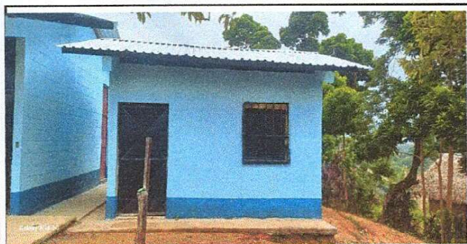
Foto 3: Como se ve en la fotografia repello termina con su pintura aplicada.
