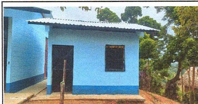
Foto 4: La sustitucion de las laminas coriente de la cocina a laminas troquelada.
